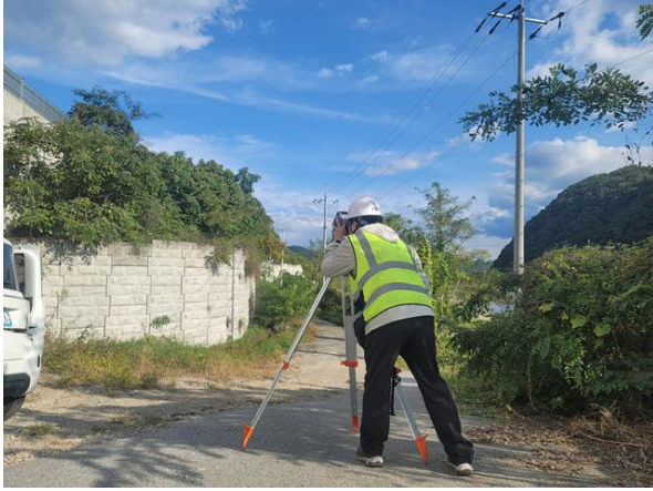
광파기를 이용한 측량 작업사진
